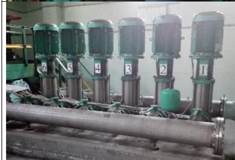
Рисунок 58 Визуальный контроль насосного оборудования ВНС №1 «Центральная»
