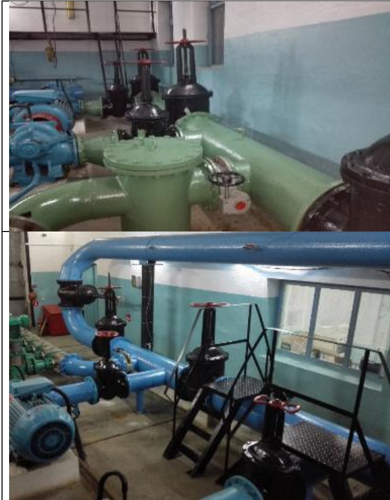
Рисунок 60 Визуальный контроль технического состояния трубопроводов и запорной арматуры
