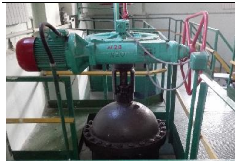
Рисунок 57 Визуальный контроль насосного оборудования ВНС №1 «Центральная»
