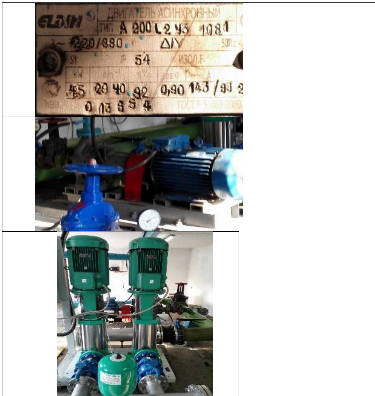
Рисунок 66 Визуальный контроль технического состояния
