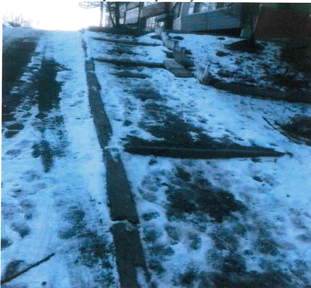
Фотография 4 – Вид лестничного марша, прилегающего к дворовой территории дома № 14 по ул. Бабушкина
